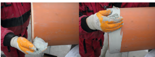
5. Nanesenie klzného prostriedku na očistené hrdlo potrubia
