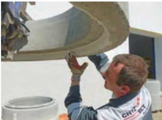
3. Osadenie jednotlivých dielov na seba
