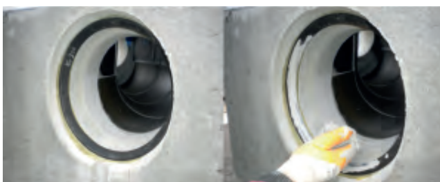
4. Nanesenie klzného prostriedku na očistený otvor šachtového dna
