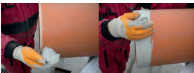
5. Nanesenie klzného prostriedku na očistené hrdlo potrubia
